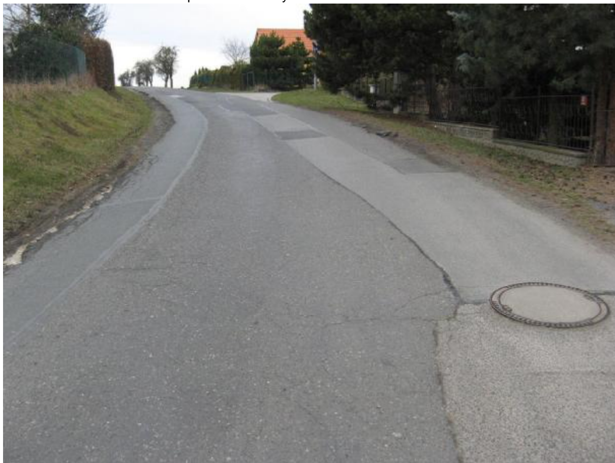
F33, km 1,510+ Olamování okraje vozovky a zapravená podélná rýha s plošnými deformacemi.
