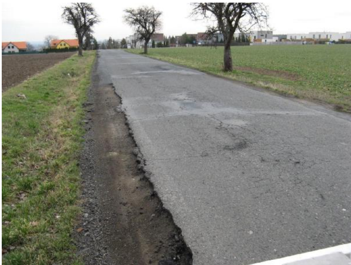
F37, km 1,800- Olamování okraje vozovky a síťové trhliny.
