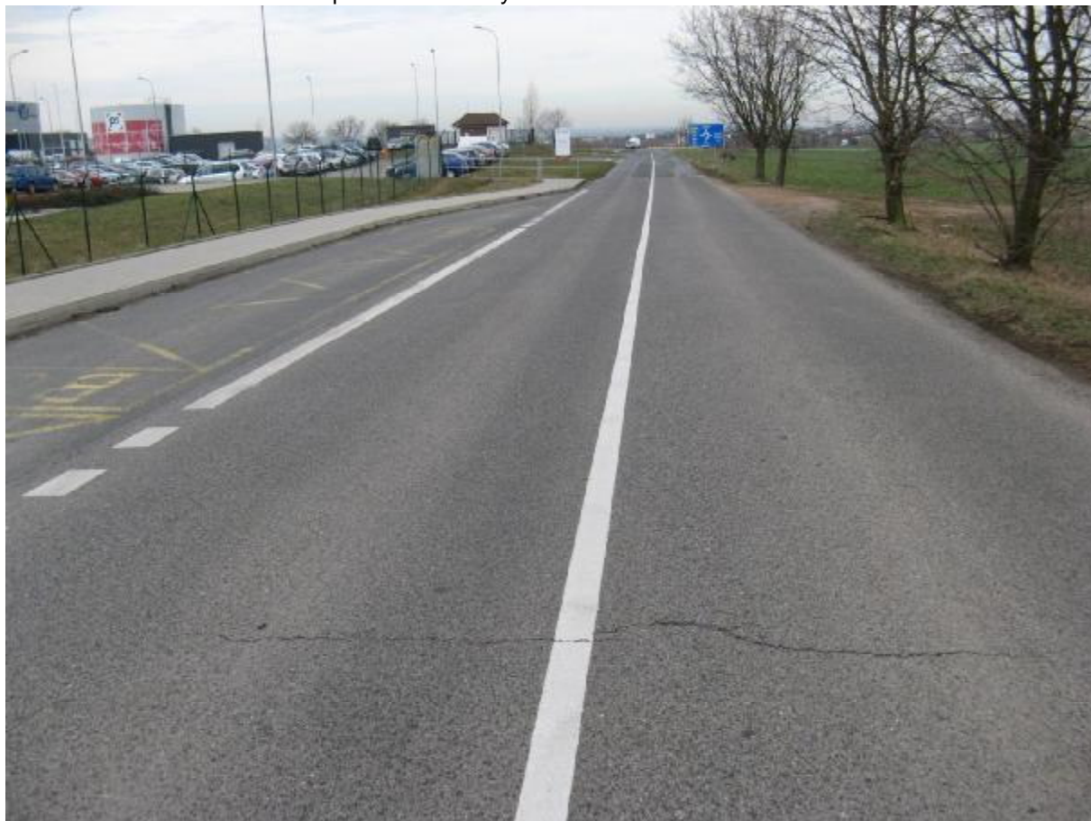
F51, km 2,410+ Ztráta asfaltového tmelu a příčné trhliny.
