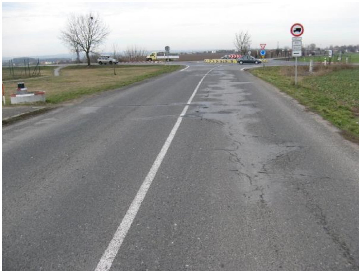
F55, km 2,610+ Mozaikové trhliny a příčné trhliny.
